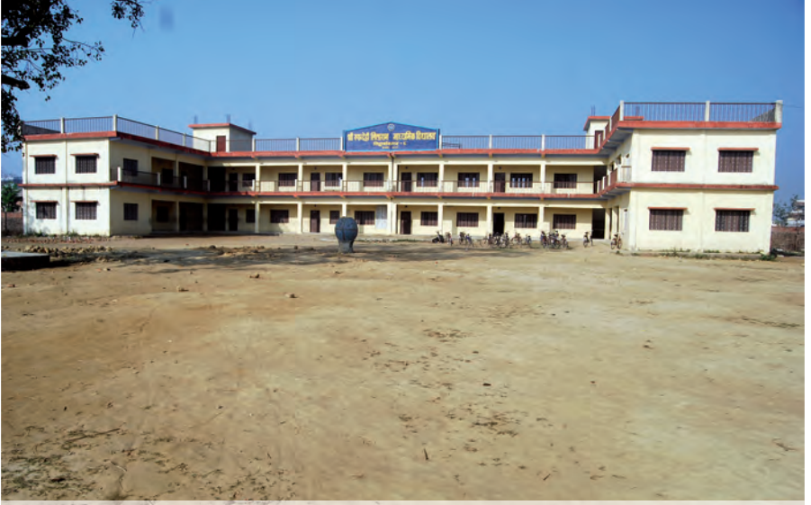
रूपन्देही लीलाराम मा. वि. को नवनिमित भवन
